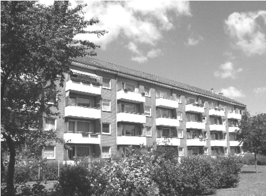
Abb. 6: Guter Zustand der Bausubstanz und trotzdem Modernisierungsbedarf – Gebäudezeile in Lübeck-Kücknitz
