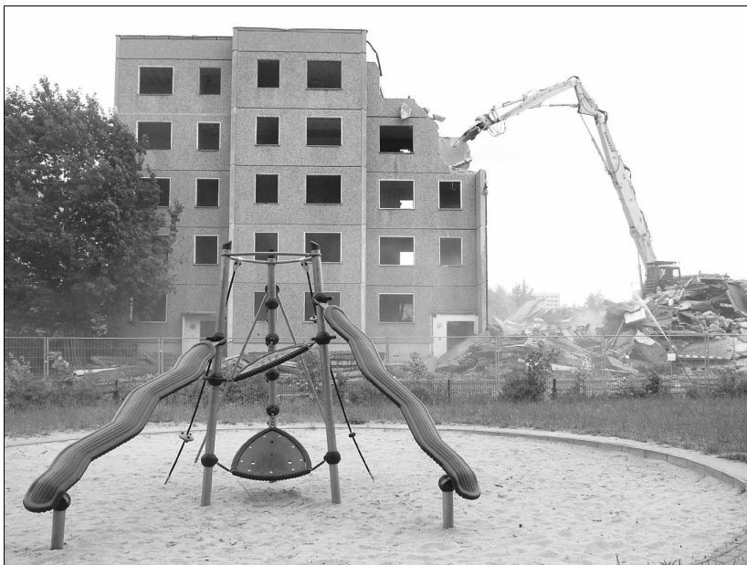
Foto 2: Abriss in Hoyerswerda-Neustadt
