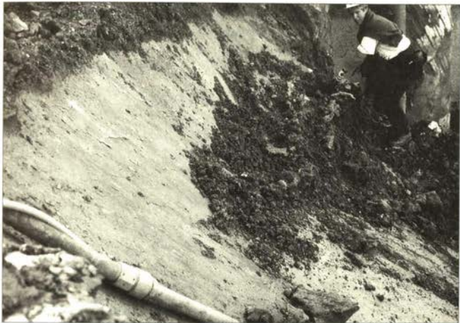
Abb. 7: Gleitfläche einer Rutschungsscholle am Tunnelportal Wandersmann Süd (Wiesbadener Kreuz)
