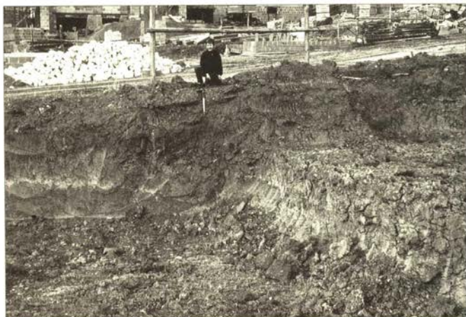
Abb. 6: Anthropogene Glättung über einer inaktiven Rutschungsscholle (Neubaugebiet Hofheim-Wallau, unterhalb der ICE-Trasse)
