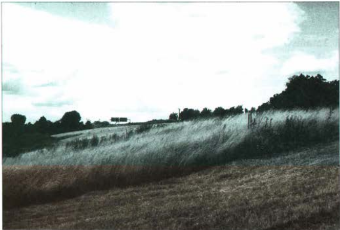
Abb. 4: Rutschungshang über den Tunnelportalen am Wiesbadener Kreuz Die Grenze des gemähten Grünlandes spiegelt sehr gut die welligen Hangkonturen wider, die durch Rutschungen im Untergrund und Verfließungen von Mergel an der Oberfläche entstehen.
