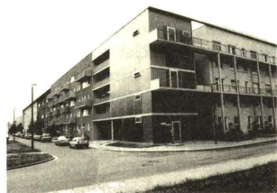
Abb. 5: Neue Ecklösung als Ergänzungsbau und vergrößerte Balkone sowie Laubengänge, teilweise zur Erschließung übereinanderliegender Wohnungen (Fotos: S. Kabisch)
