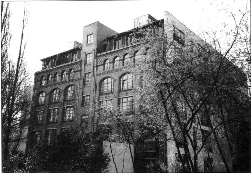
Abb. 1: Frontalansicht Lofthouse Melchiorstraße, Berlin, Quelle: BÜTTNER 2002
